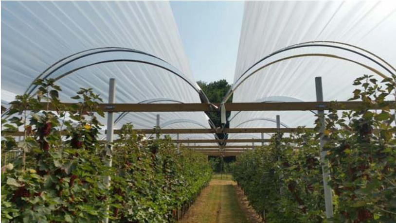
Die Bögen sind vollverzinkt mit Löchern vorgebohrt, ohne Grad. Die Maße der Bögen sind individuell nach Bedarf in Länge und Radius konfigurierbar. Als Untergerüst kann man Holzpfähle oder Betonpfähle wählen. Die Holzlatten sind Salzimprägniert.
